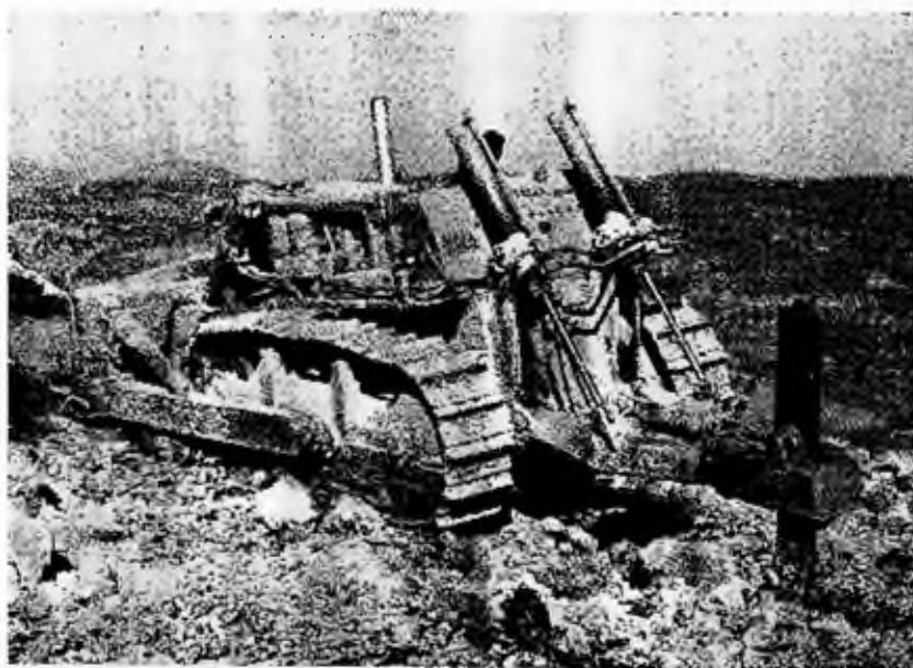
Fig. 18.2 - Trattore Caterpillar D 9 attrezzato con ripper e bulldozer (Soc. M.A.I.A., Roma)
