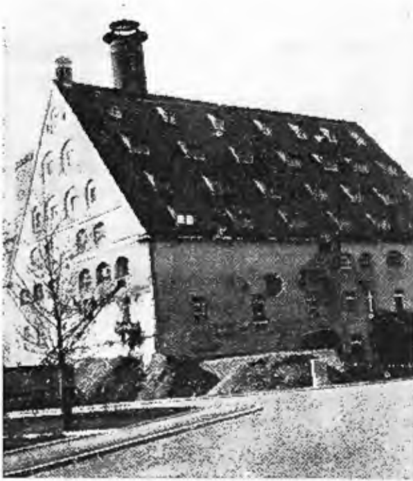
Fig. 17.24 - Terrapieno di protezione intorno alla parte di edificio da abbattere per prima (Nobel Hefte)
