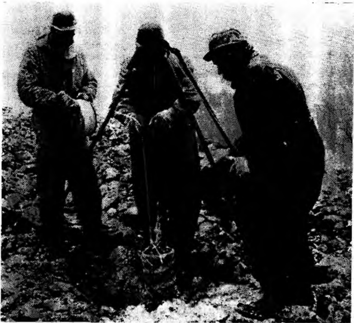
Fig. 13.4 - Discesa nel foro di una grossa cartuccia contenuta in una rete a grandi maglie (Blasting Practice, 3 a ed., 1962, Imp. Chem. Industries)
