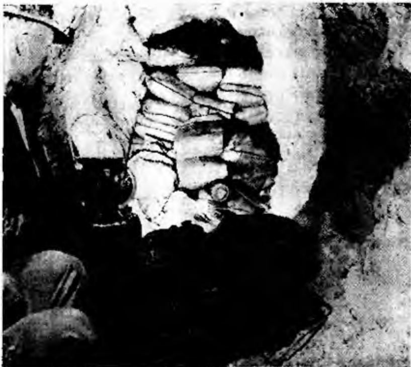
Fig. 13.33 - La carica bene sistemata in una camera (Blasters' Handbook, 15 a ed., 1966, Du Pont)
