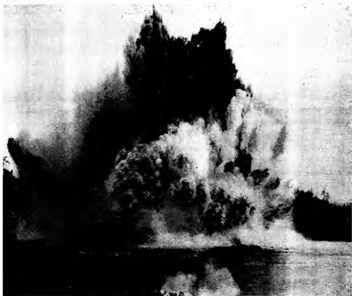
Fig. 13.37 - Esplosione della grande mina, a due camere, di Ripple Rock (Canada), caricata con 1 240 t di esplosivo (Blasters' Handbook, 15ª ed., 1966, Du Pont)
