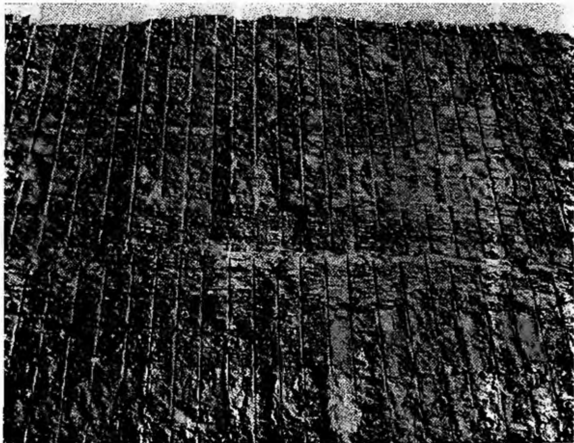
Fig. 13.21 - Fronte di scavo ottenuta con taglio preventivo, con fori a 60 cm (dallo studio di cui alla nota [13.17])
