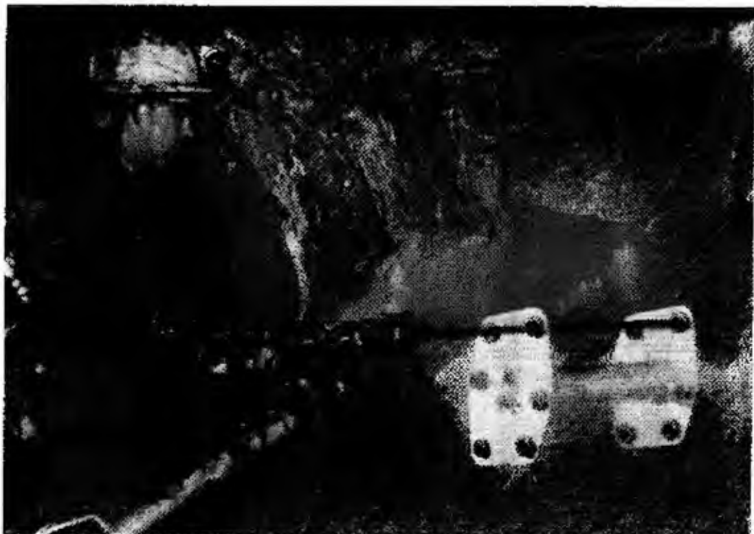
Fig. 6.13 - Esecuzione dei fori di diametro normale dell'intesto Coromant con la apposita sagoma: i tubi centrali sono infilati nel doppio foro centrale, eseguito in precedenza
