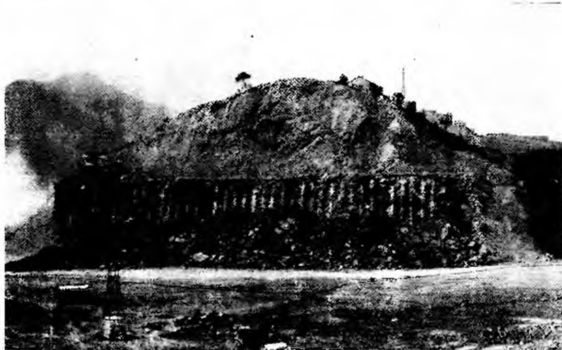
Fig. 16.5 Brillamento di una volata costituita da una fila di mine profonde e da mine di rilevaggio con intervalli di millisecondi nella cava « Montecroce » dell'ing. Brino a Genova-Cornigliano: in alto il brillamento, in basso l'effetto della volata
