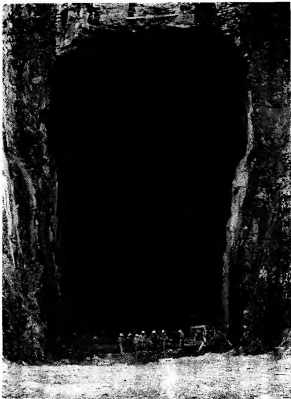
Fig. 6.22 - L'imbocco della galleria di Stornorrfors: larghezza 15 m, altezza 27,5 m
