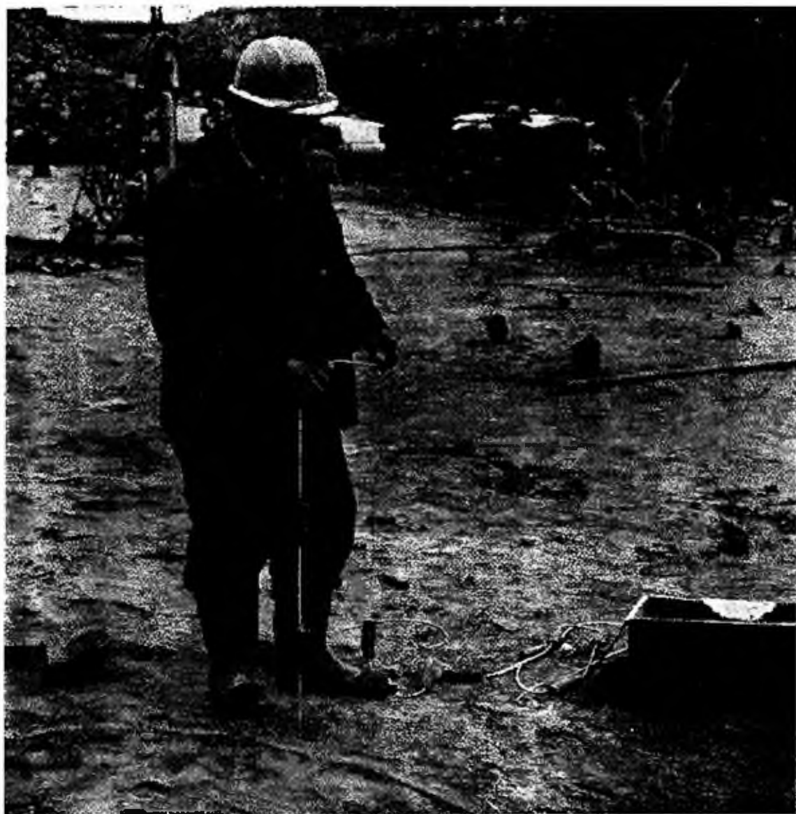
Fig. 13.23 - Introduzione della miccia detonante armata con cartucce spaziate (foto G. Morrison, Ayr, apparsa nell'articolo di cui alla nota [13.20])
