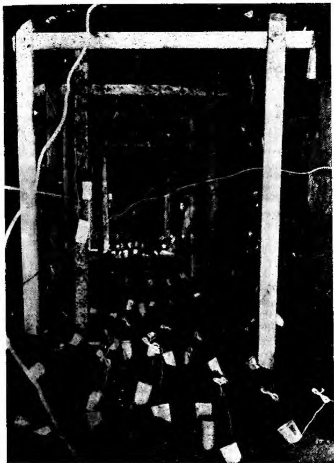
Fig. 16.38 - Una delle cento gallerie di preparazione della volata di cui alla figura precedente: sono visibili le bocche delle mine caricate e collegate per l'accensione elettrica
