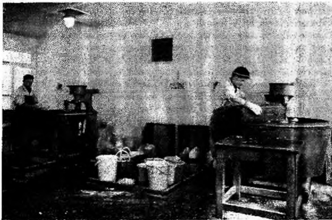
Fig. 8.66 - Interno del locale di mescolamento per la fabbricazione in situ di slurry Cosimex nella miniera di carbone Westfield, Scozia (Mining and Minerals Engineering, National Coal Board Opencast Executive, Costain Mining Ltd. - Foto Gordon, Town Centre Glenrothes)
