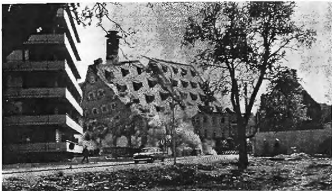
Fig. 17.26 - L'abbattimento della prima metà dell'edificio di cui a fig. 17.24 (Nobel Hefta)
