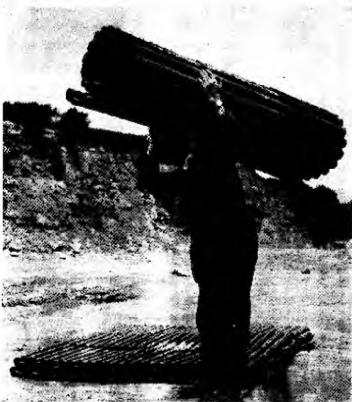
Fig. 10.2 - Stuoie di tubi di polietilene « Columbus » per evitare il lancio a distanza di detriti nelle volate all'esterno (Artie Shaw)
